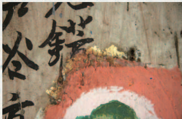
二荒山神社本殿東妻入破風束の金箔痕跡 (写真提供: (公財)日光社寺文化財保存会)
